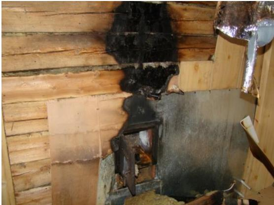
Одной из самых распространенных причин пожаров в частном жилье становится печь, эксплуатируемая в бане. Основные причины таких возгораний – нарушение правил пожарной безопасности при её устройстве и эксплуатации.
